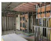
通電前の屋内作業に
